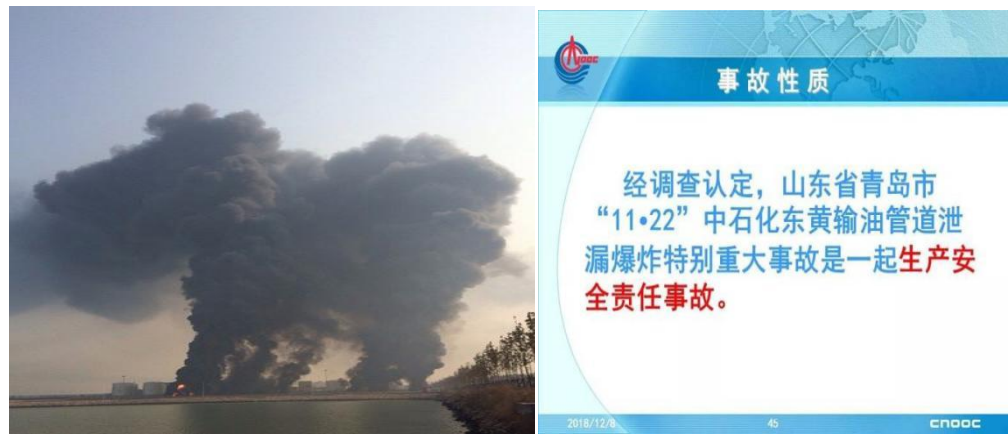
图 1 山东青岛“11·22”中石化东黄输油管道泄漏爆炸
