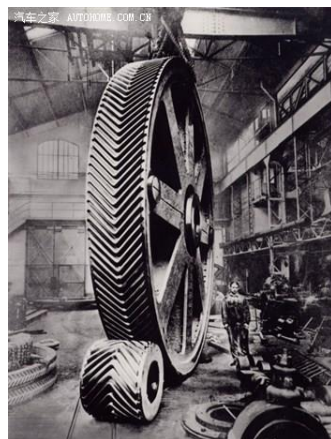
安德烈·雪铁龙在1905年的一次旅行中购买了人字形齿轮欧洲的专利权，回国后便创立了雪铁龙齿轮厂。雪铁龙齿轮热销后，他便动身前往美国参观福特工厂，随即便浮现出生产汽车的念头。
