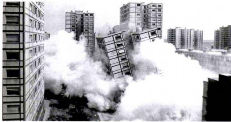
法国里昂某住宅楼因问题重重而被引爆炸毁(1983)
