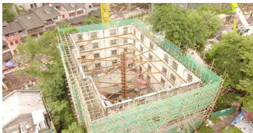
内部掏空后的，用钢结构支撑外墙
